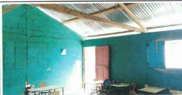
Foto 5: Interior de las aulas donde se requiere repello de la pared, cambio de techo.
